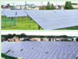
帯広市内2カ所に太陽光パネルを設置しています
